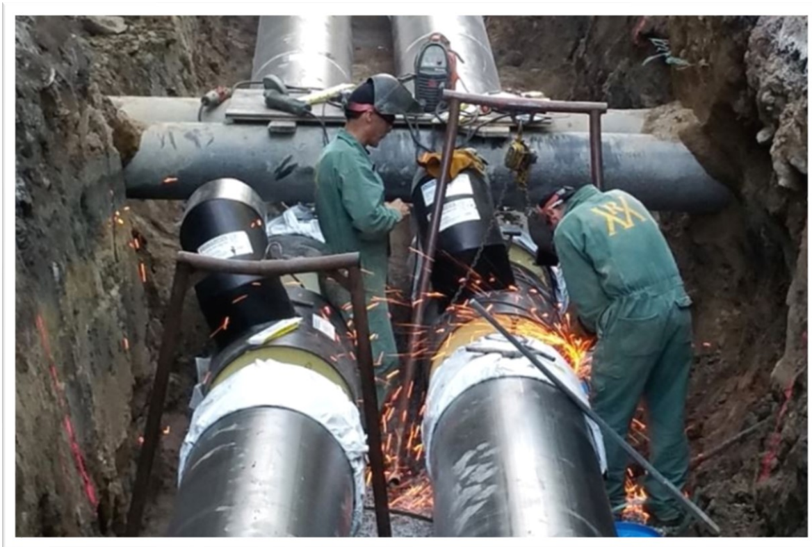
Exempelbild på svetsning av kulvertledning
