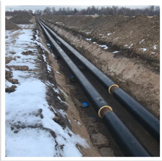
Exempelbild på kulvertledning
